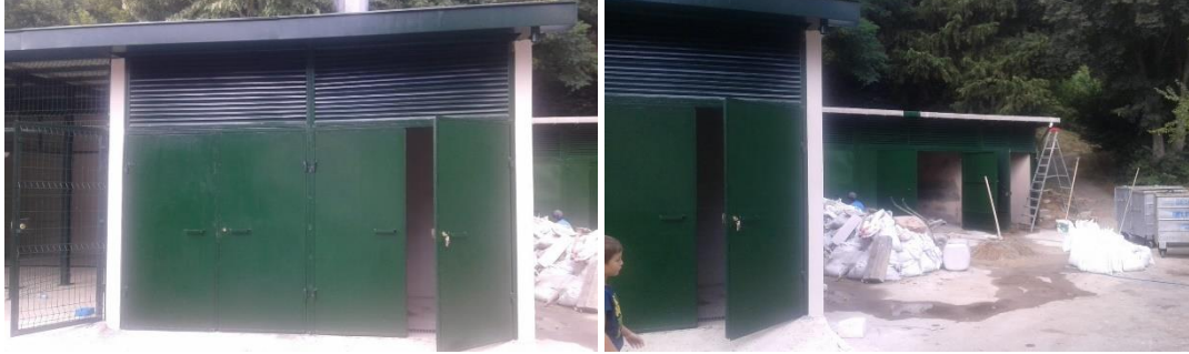
Şekil 18. Boğaziçi Üniversitesi Ara Depolama Sahası.
