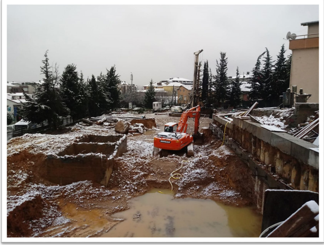
Kandilli Yapı Laboratuvarı Hafriyat ve Kazık İmalatları
