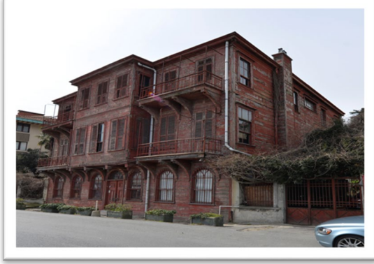
Halet Çambel Restorasyonu Öncesi
