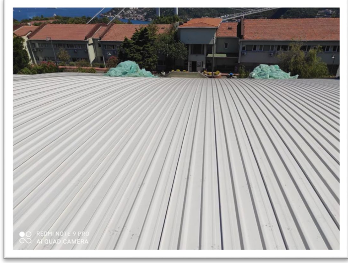
Kilyos Kapalı Yüzme Havuzu Kenet Metal Çatı Kaplaması
