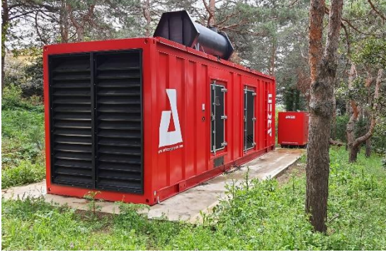
Kandilli Kampüsü 1650 KVA Jeneratör
