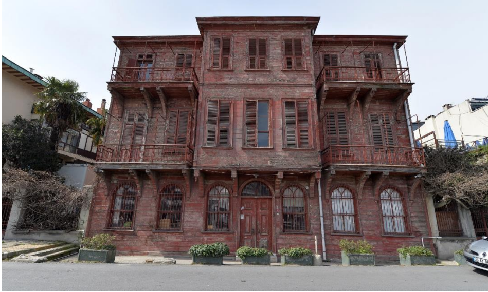
Halet Çambel Restorasyonu Öncesi
