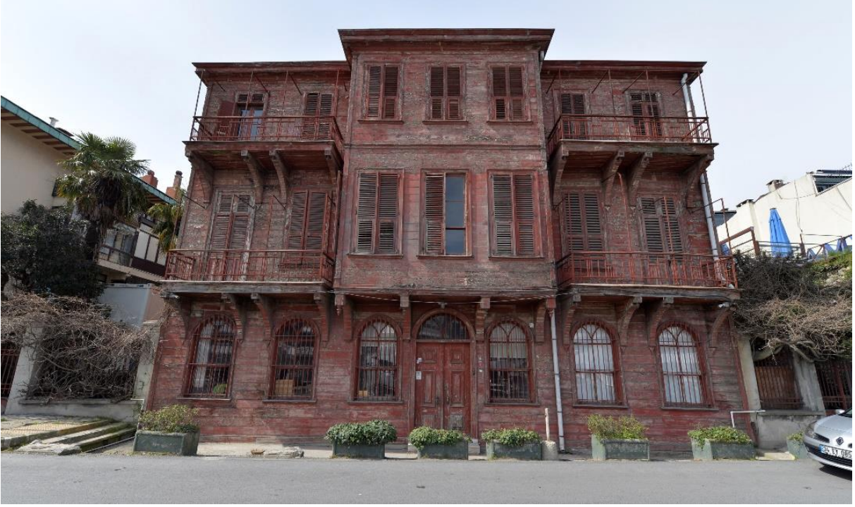
Halet Çambel Restorasyonu Öncesi
