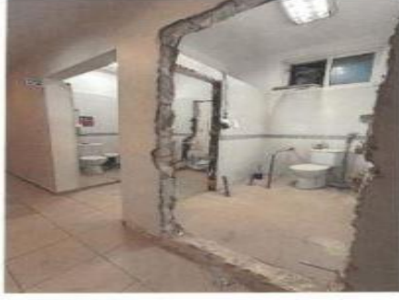
Şekil: Revir Binası Islak Hacim Kırm İşleri
