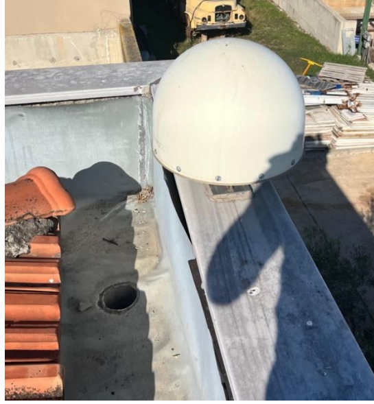
Şekil 4 MAVI istasyonuna ait iyileştirme ihtiyacı saptanan GNSS anten konumuna ait görüntü
