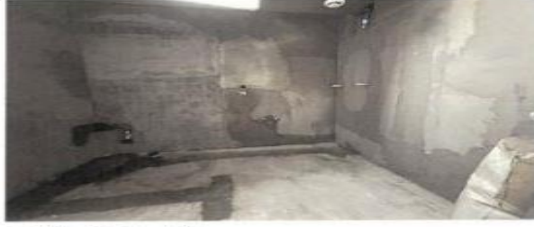
Şekil: Revir Binası Islak Hacim Yalıtım İşleri
