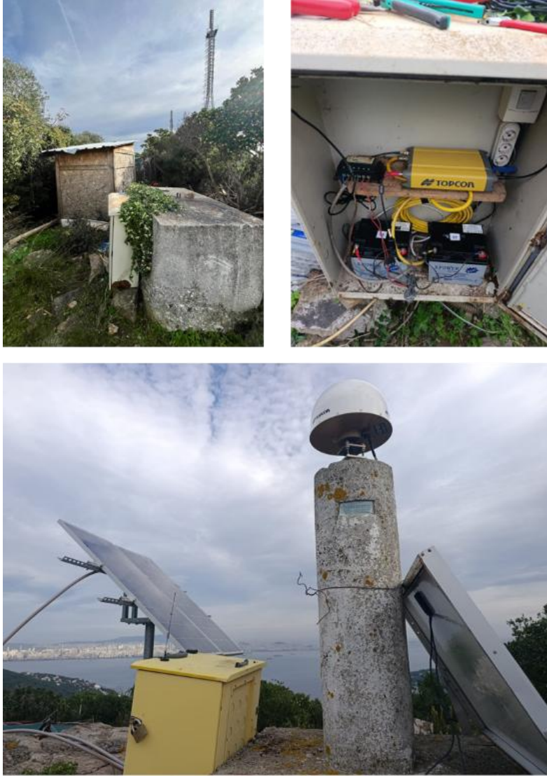
Şekil 2 MarmNET GNSS gözlem ağına ait Büyükada’ da bulunan BUYU istasyonunun kaldırılıp yerine kurulan BAD1 istasyonuna ait görüntüler
